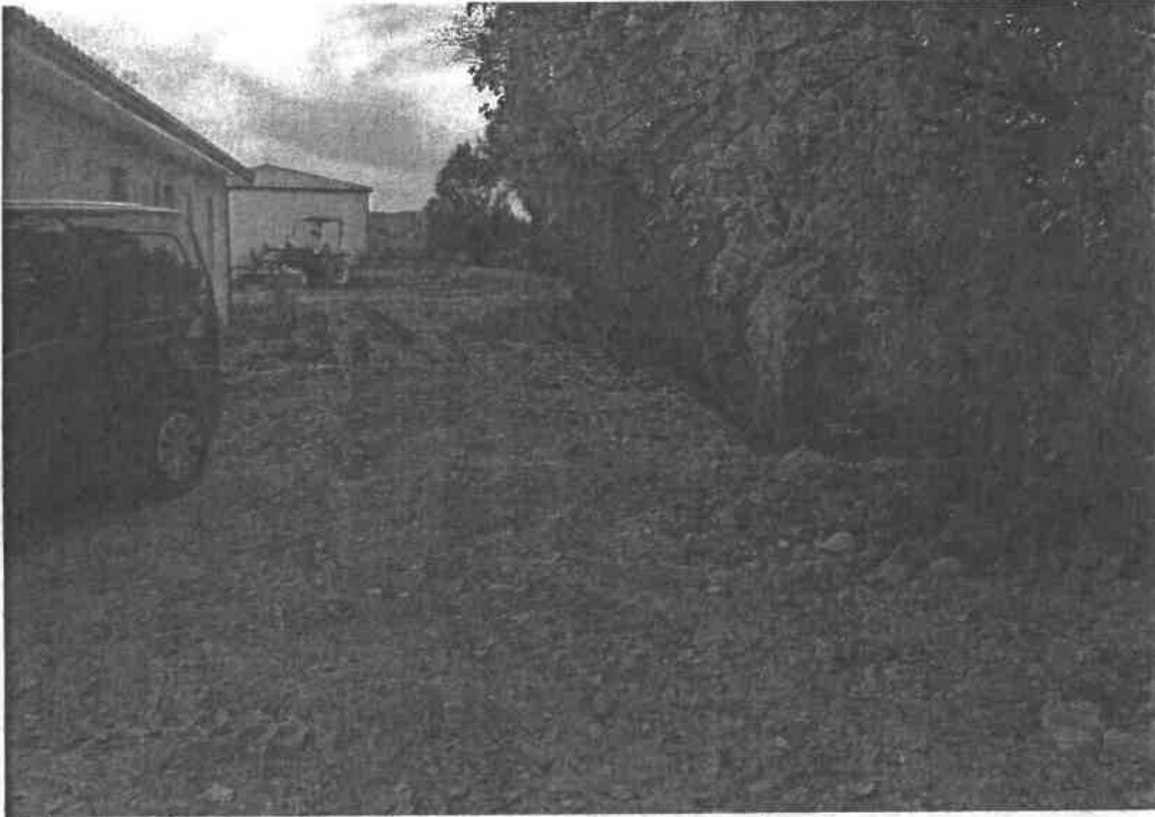
Vue du remblai depuis la parcelle AS 53
