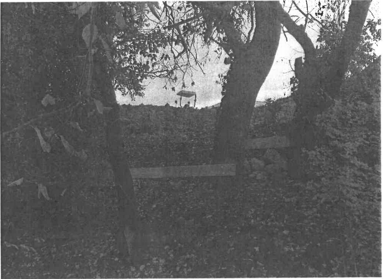
Prise de vue du remblai depuis la rive opposée
