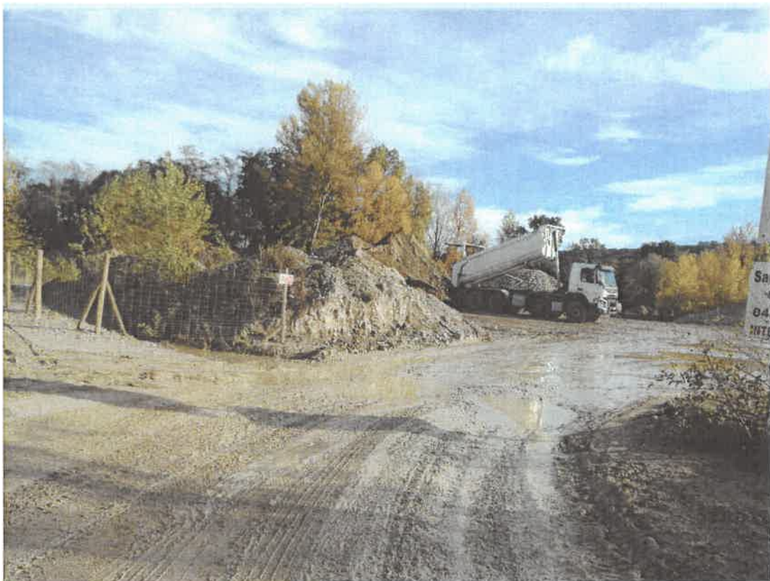
*Remblai de terre et dépôts de matériaux sur les parcelles B 0979 et B 0982
